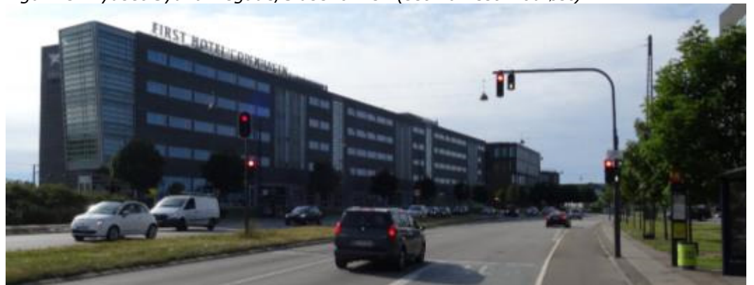
Figur 16 Gatingsignal øst for krydset Sydhavnsgade/Sluseholmen (set fra øst mod vest)
